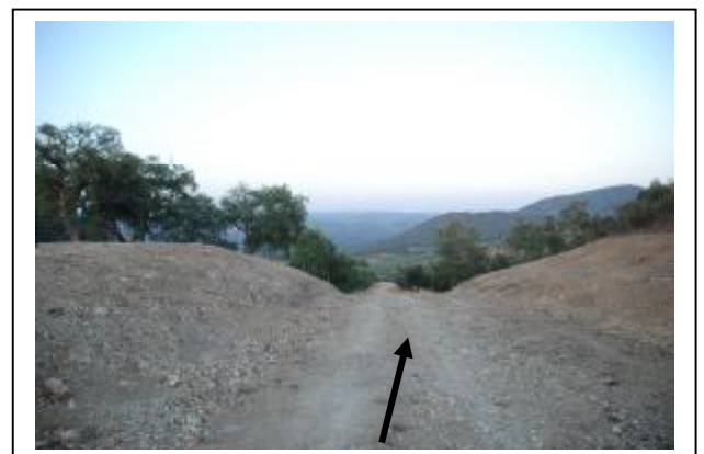
LUGAR DESTINADO AL MIRADOR Y QUE EN BREVE SE INICIARA SU CONSTRUCCIÓN
